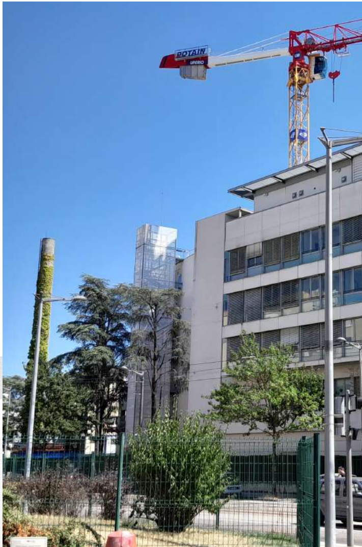
VUE 1 AVANT TRAVAUX
