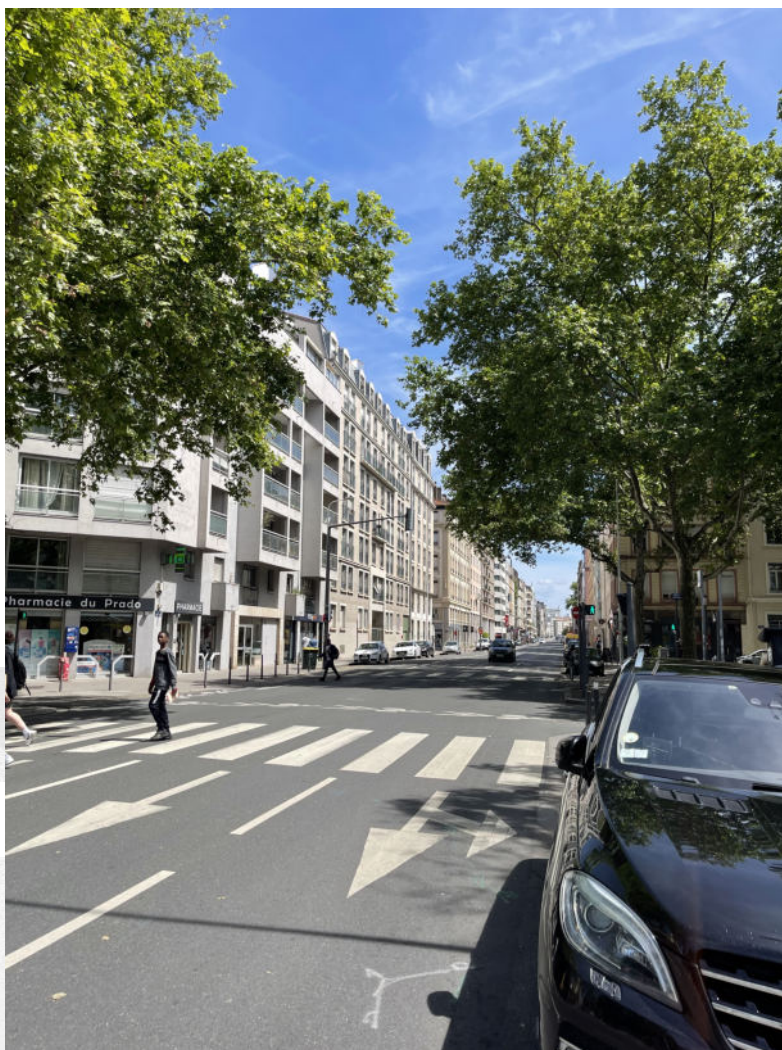
VUE 1 AVANT TRAVAUX
