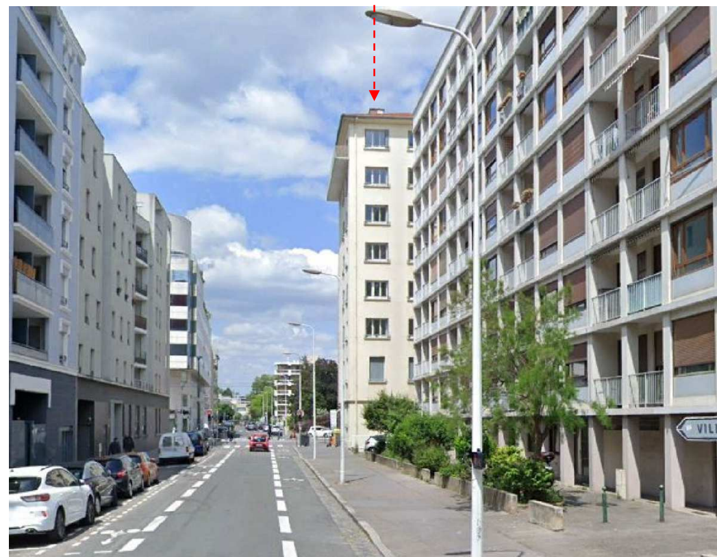
VUE 2 APRES TRAVAUX Pas d'impact visuel
