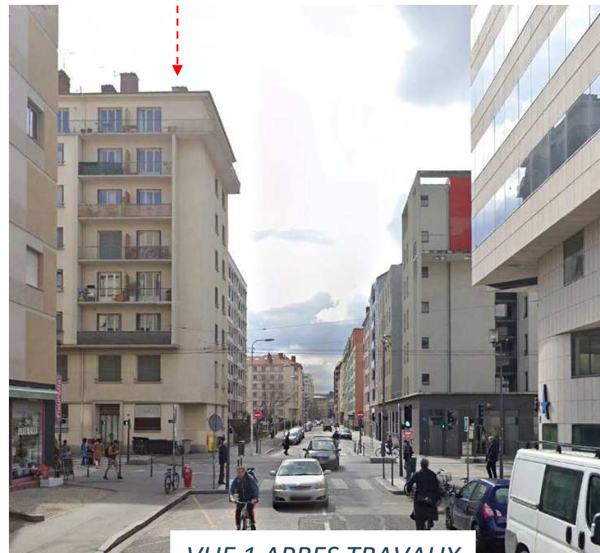
VUE 1 APRES TRAVAUX
