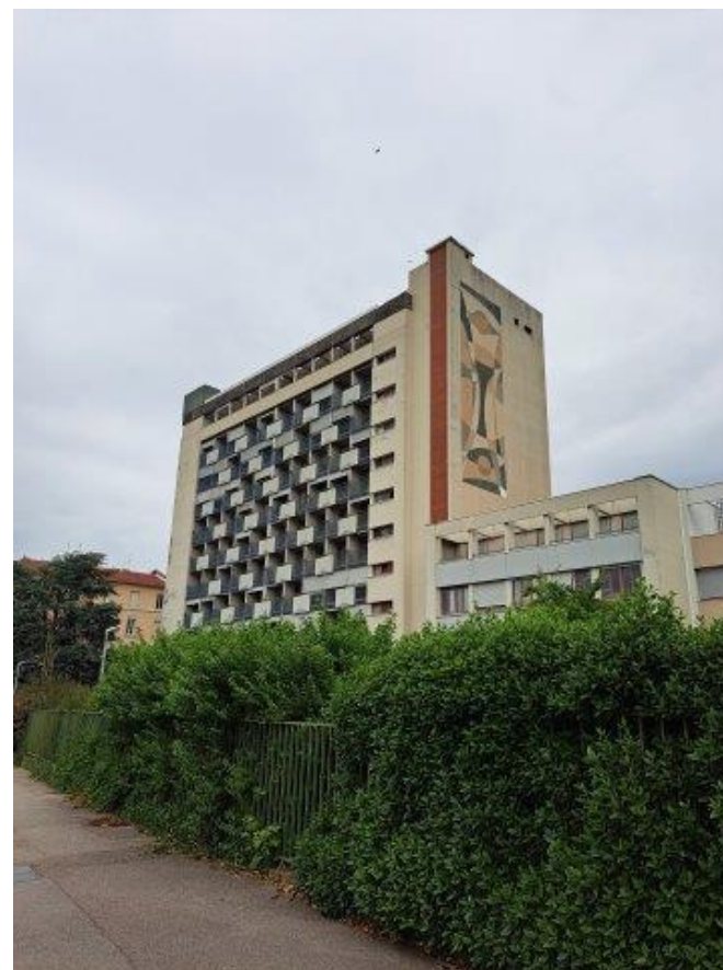
VUE 1 APRES TRAVAUX
