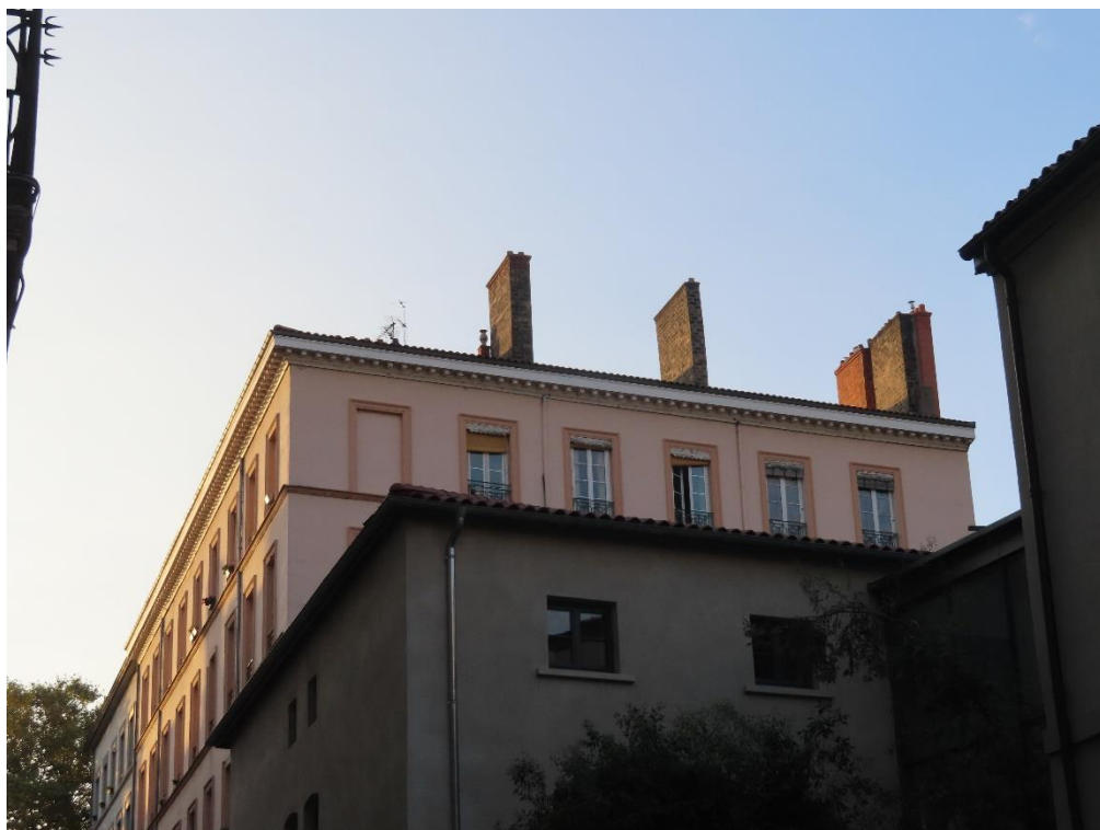
VUE 1 AVANT TRAVAUX
