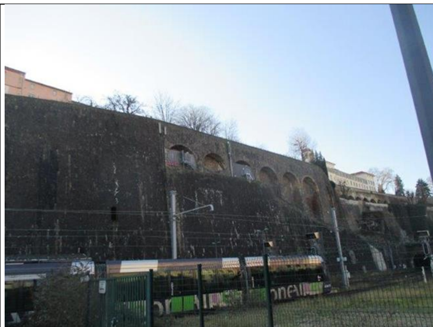
VUE 1 APRES TRAVAUX
