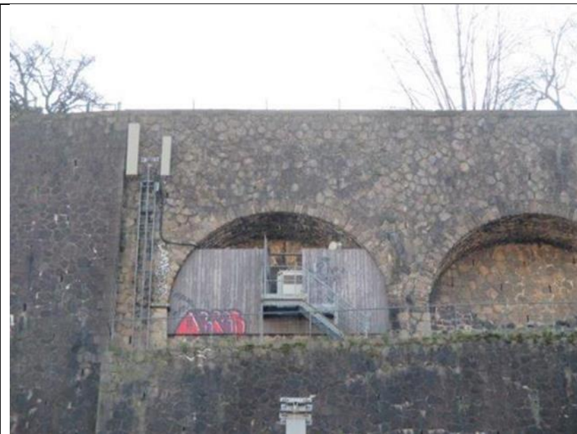
VUE 2 APRES TRAVAUX
