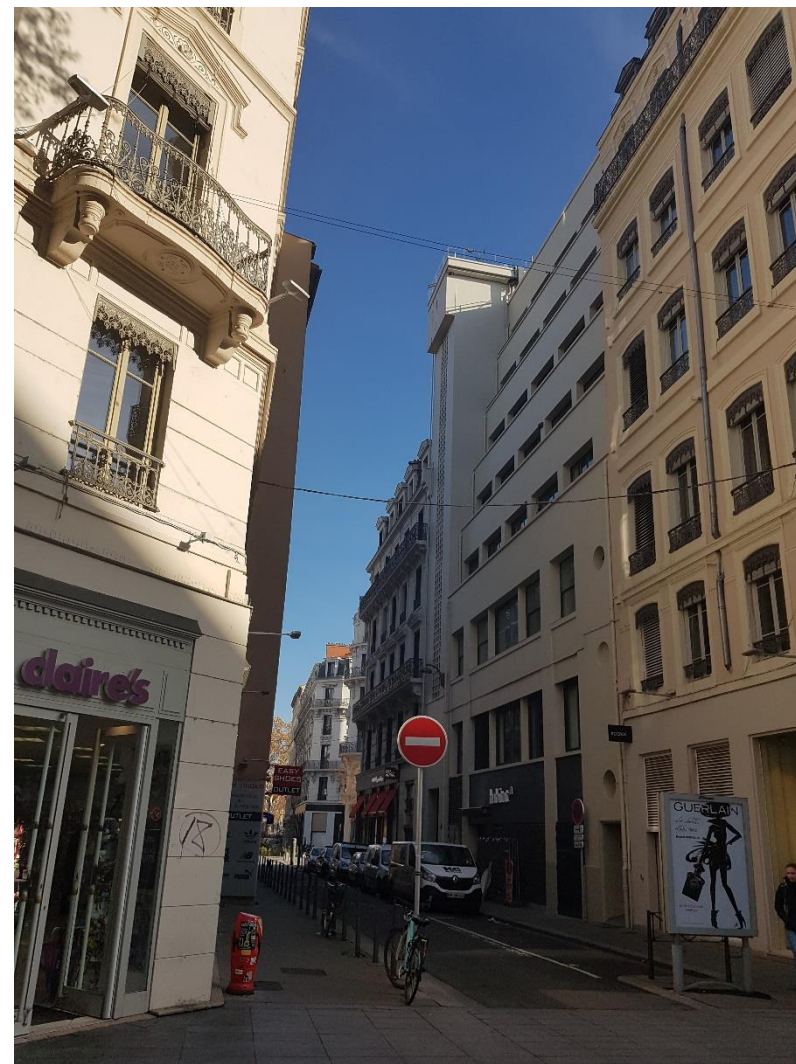
VUE APRES TRAVAUX
