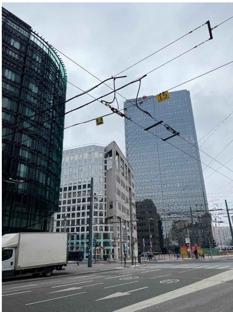
VUE 3 AVANT TRAVAUX
