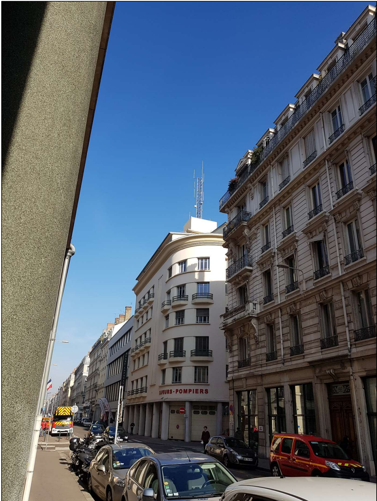
Vue de l'immeuble en façade
