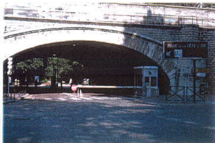
La voûte Boulevard de Stalingrad
